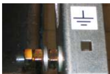
а) болт заземления
